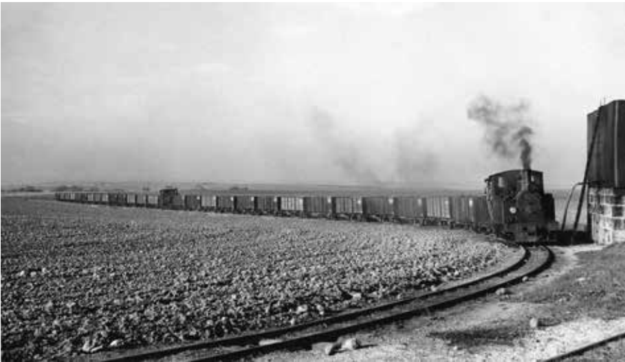
La voie étroite de 60 cm de rayon se contente de rayons de quelques dizaines de mètres, comme ici sur le réseau betteravier de Maizy.
